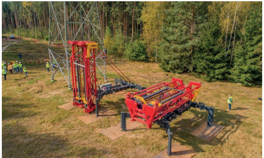
Rys. 8. Słup na wstawce podwyższającej, podnośnik w pozycji roboczej i składowania
