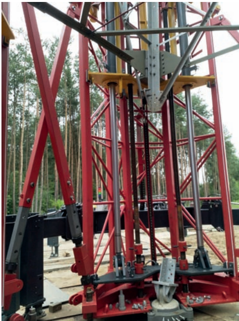
Rys. 6. Układ podnoszenia z uniesionym słupem
